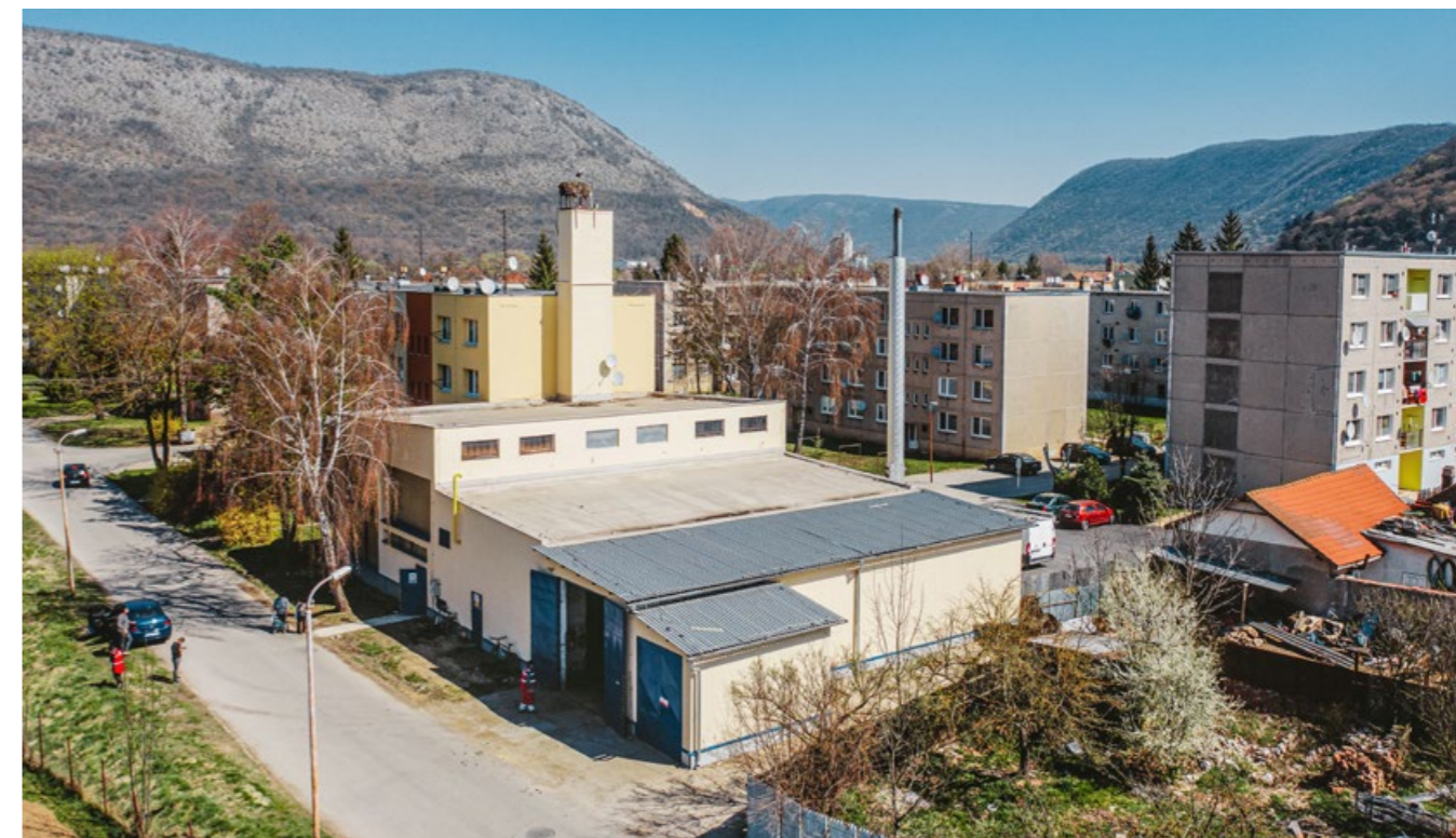
Kompletná výmena rozvodov tepla a rekonštrukcia budovy kotolne a komína s bocianím hniezdom v Plešivci.
