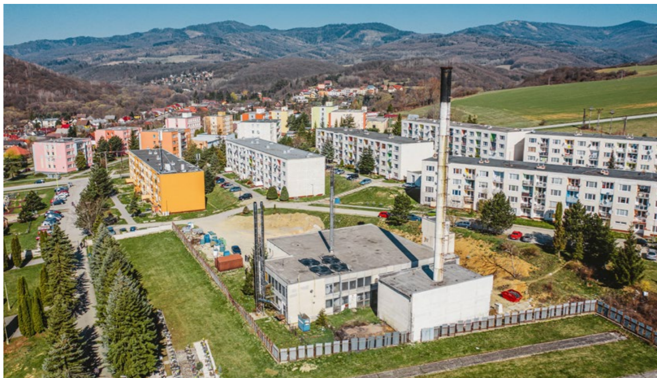
Biomasová a plynová kotolňa v Medzeve po kompletnej výmene rozvodov tepla na sídlisku Mladost'
