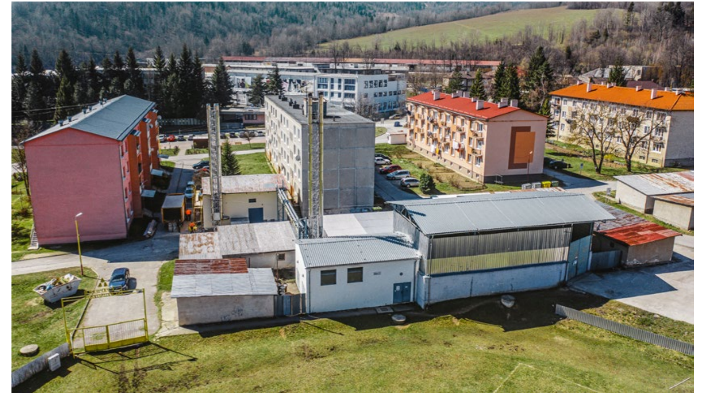
Biomasová a plynová kotolňa v Slavošovciach po kompletnej výmene rozvodov tepla.
