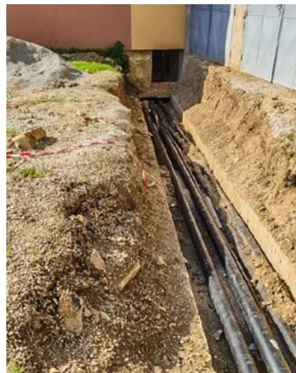
Modernizácia rozvodov v Plešivci
