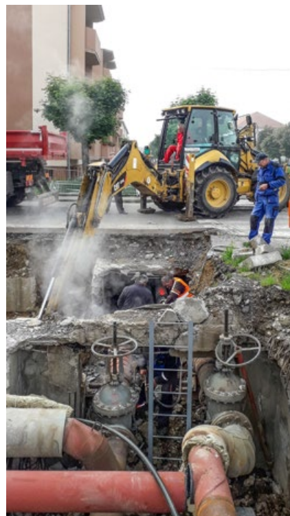
Modernizácia rozvodov v Žiari nad Hronom
