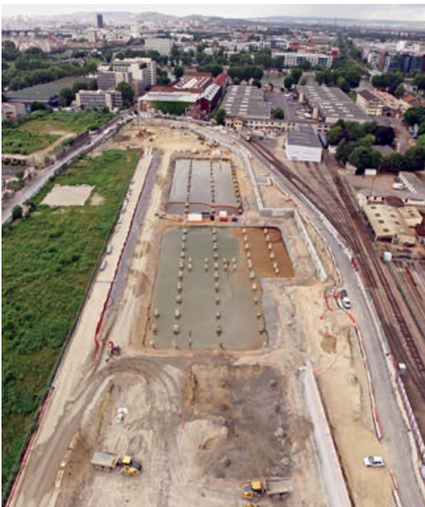
V Saint-Ouen vo Francúzsku spoločnosť GRS Valtech vyčistila pozemok určený na umiestnenie prevádzky údržby a skladovacích priestorov na vagóny z trasy 14 parížskeho metra.
